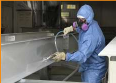
Aplicación de Pintura
